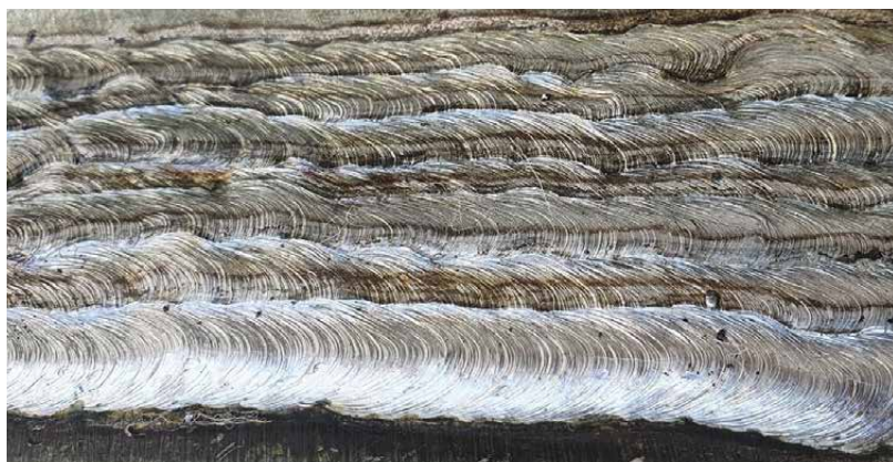
Decklagen mit feinschuppiger Nahtoberfläche ohne Porosität oder Einschlüssen
